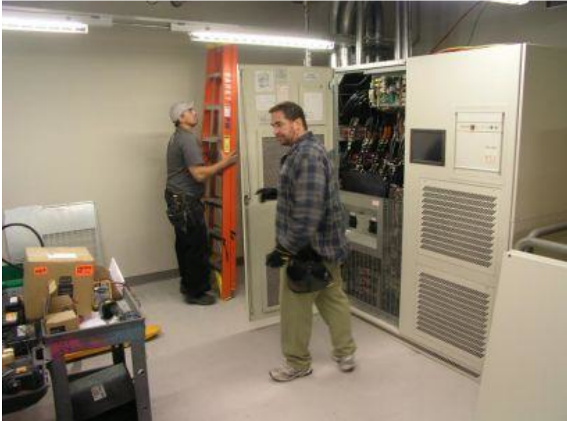
Figura 48: SAI para una gran instalación
